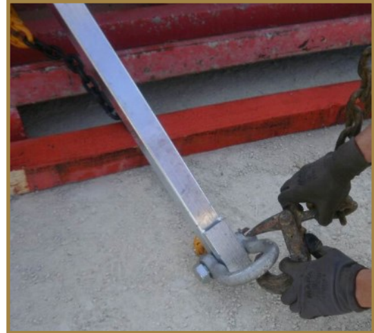
9 - Fixer les élingues de la grue sur les anneaux des béquilles droite et gauche.
