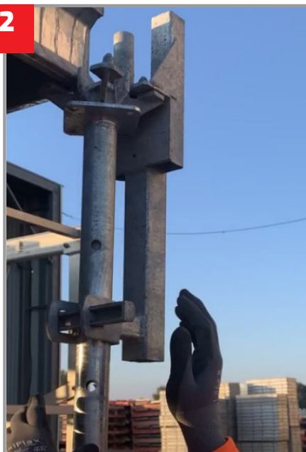
Clavetter le support potelet sur l'étau
