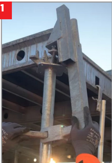
Positionner le support potelet sur la tête
