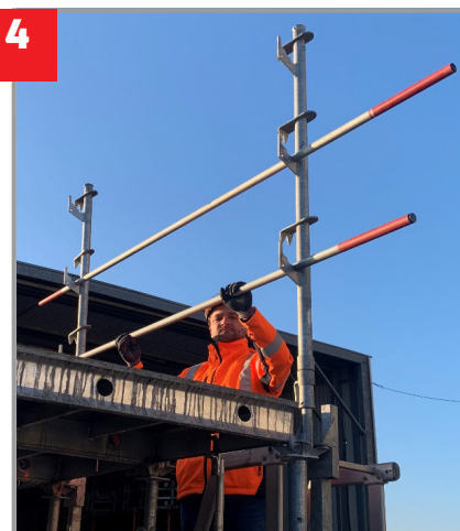
Positionner les lisses G-C sur les potelets
