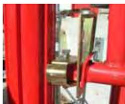
**2** - Mettre en contact les rainures du fût de l'étais avec les mâchoires à ressort du cadre treillis.
