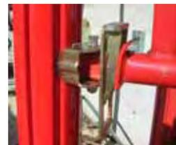
**3** - Frapper sur la clavette de serrage par l'usage modéré d'un marteau de coffreur.
