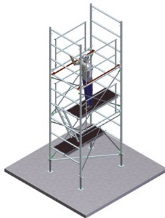
5 METTRE EN PLACE 2 LISSES A CLAVETTES sur barreau.
