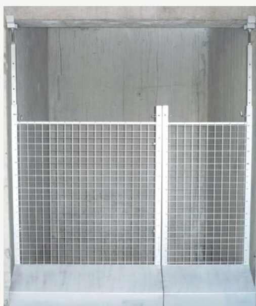
Liaisons des baies fixes par boulonnerie
