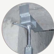
Blocage de la bale avec équerre à vis
