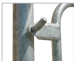
Système d'accrochage supérieur des garde-corps
